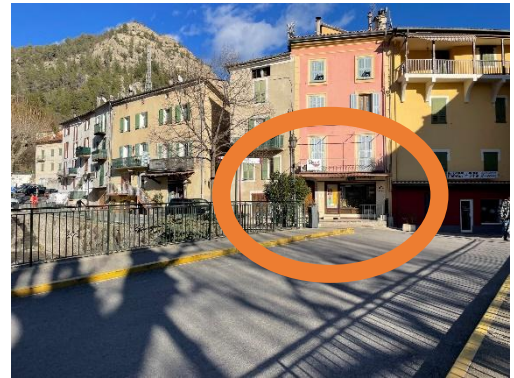
Image 1. Vue de face du local
